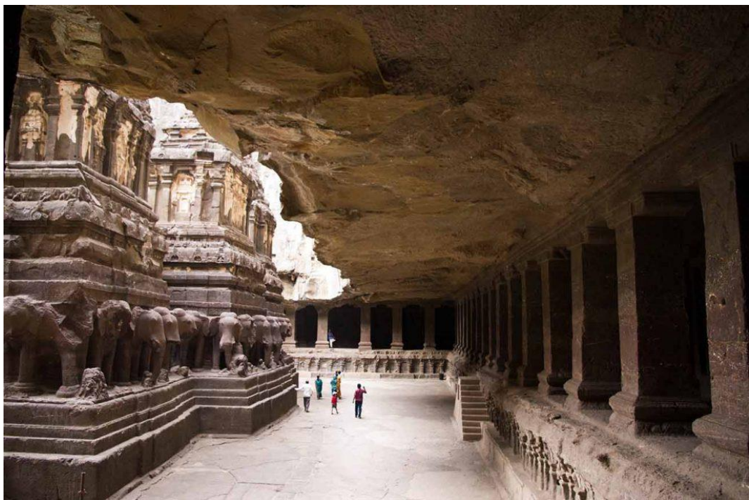
Рис. 17. Защитные навесы по периметру храма Кайлаш работы по формированию плоских поверхностей столовых гор для их обустройства (рис. 18-19).
